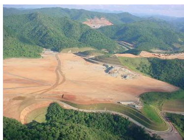
Aterro em APP e construção da fábrica de cimento de CBE (rio das Almas/Rib. Grande).
